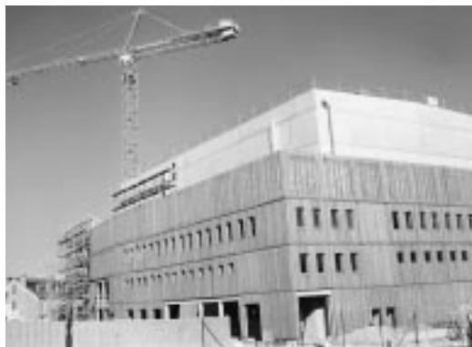
Les façades en bois d'ipé de la nouvelle salle de spectacle de Quimper.
